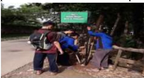
Gambar 1.6. Pemasangan Rambu-Rambu Islami
